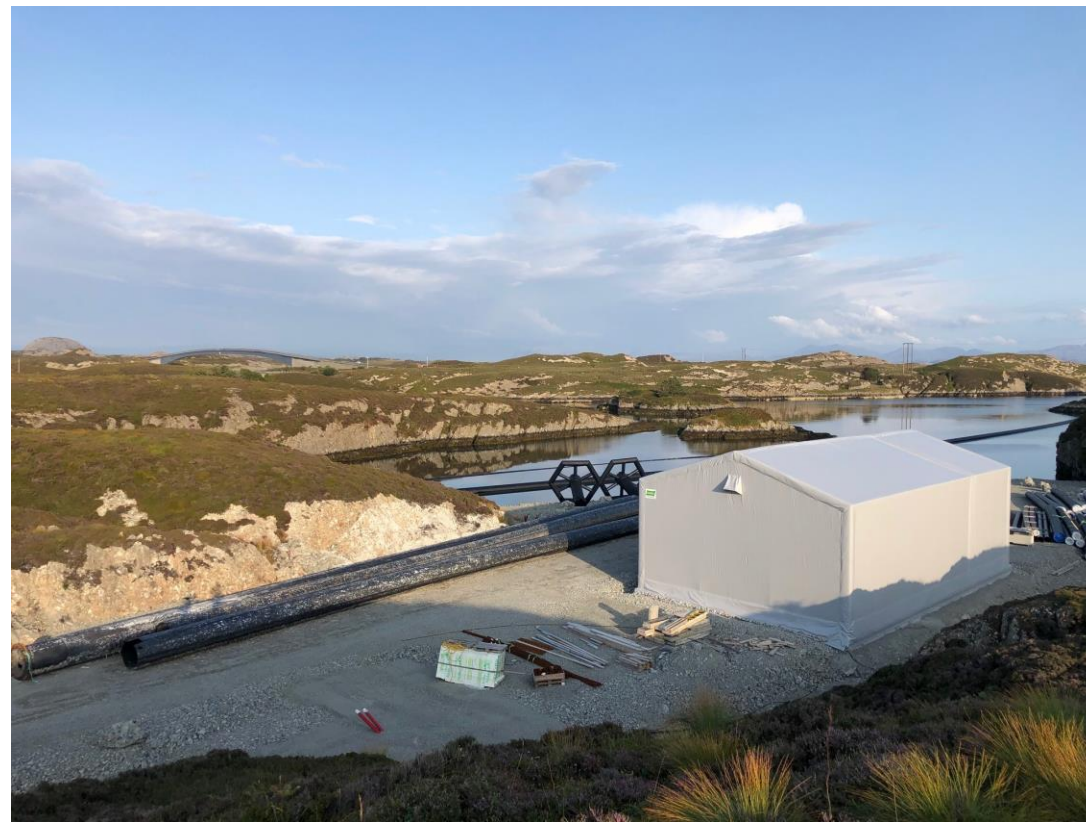
Kaiområde under oppbygging
